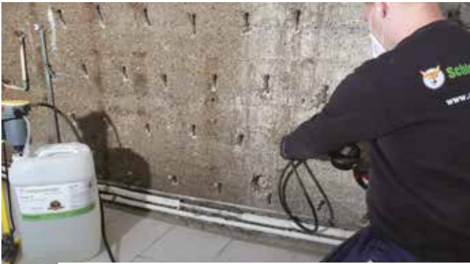
Dank des innovativen und bewährten Produktes ist – selbst bei starker Durchfeuchtung – keine Ausschachtung notwendig. (Fotos: Schimmelfuchs Abdichtungstechnik GmbH)
